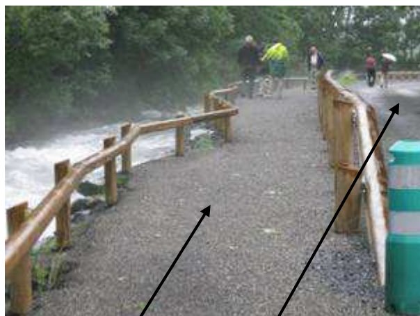
Parcours de pêche stabilisé et protégé de la circulation routière.
