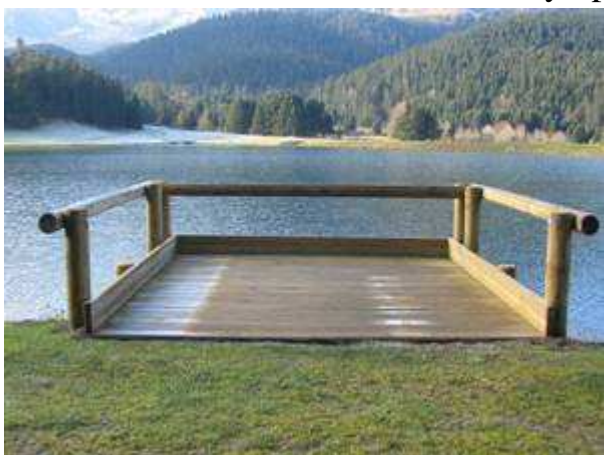
Ponton à plusieurs places : 3m00 de côté. Garde-corps mal positionnés car hauteur unique.
